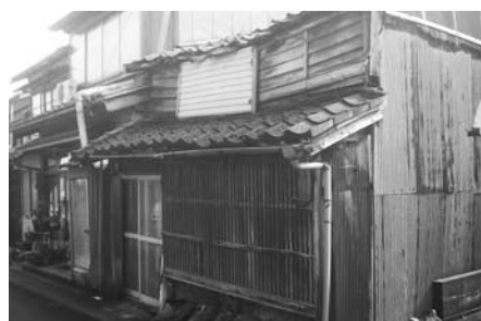
倒壊の危険性がある空き家の状況
