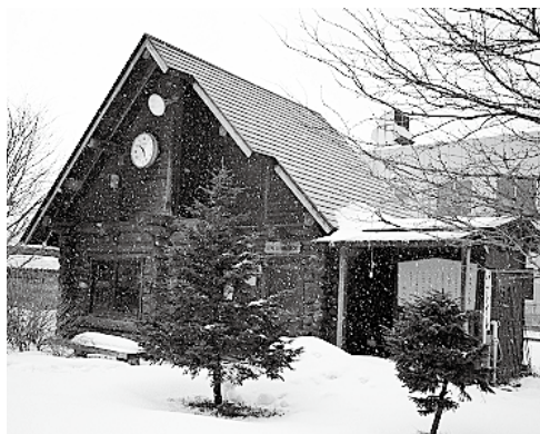
町屋広場のトイレ（上町）
