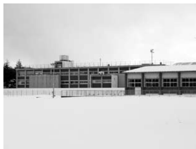
耐震化工事中の村上第一中学校
