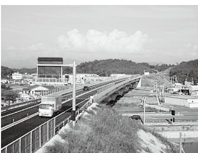
日本海沿岸東北自動車道
