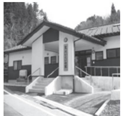
新築開館した荒川いこいの家
