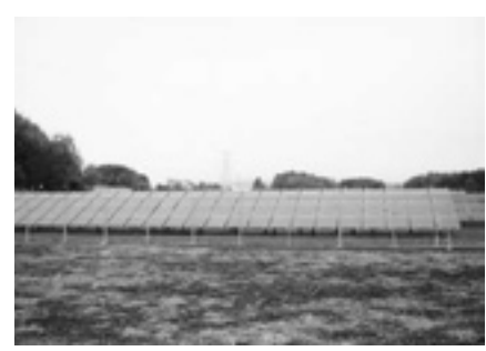
山梨県北杜市の太陽光パネル
