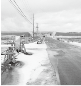
工事が進む神林インター(仮称)
