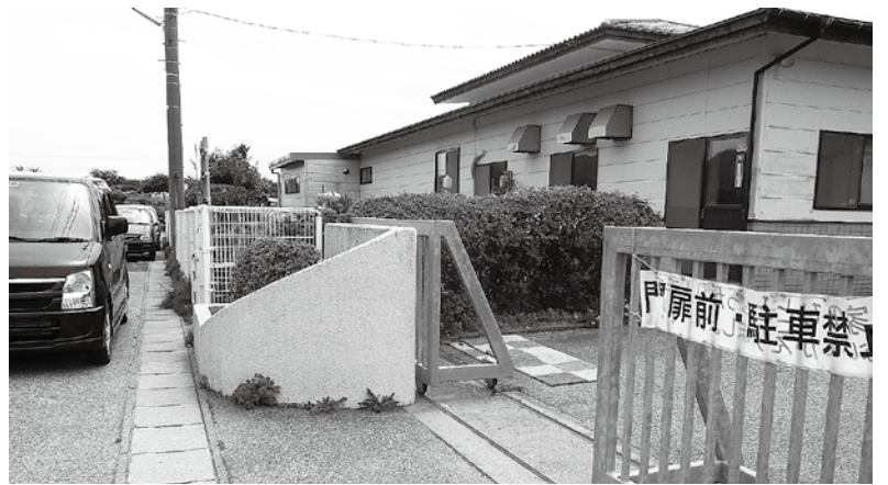
駐車場工事が予定される瀬波保育園
