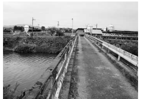
新飯田地内の宮ノ越橋
