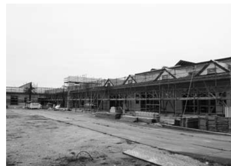
建設進む「あらかわ保育園」(10月24日現在)
