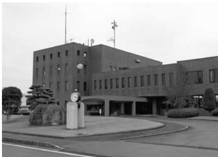
地域振興の重要な役割を担う各支所(朝日支所)
