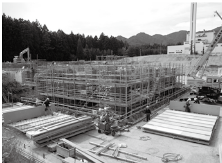
新ごみ処理場の建設状況 (平成25年9月末現在)
