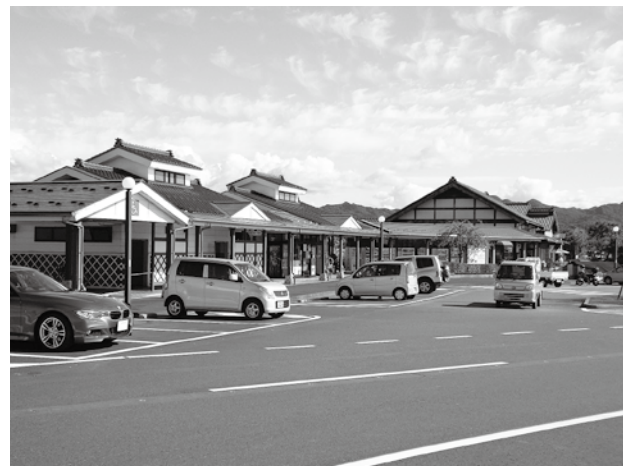
電気自動車の充電器が設置される「道の駅 神林」
