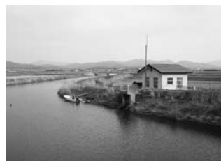
八日市第一排水機場
