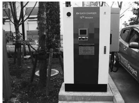
道の駅朝日に設置されるものと同等の「急速充電器」
