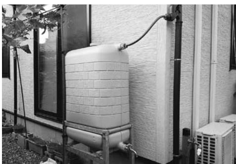
一般家庭で使用されている雨水貯留タンク
