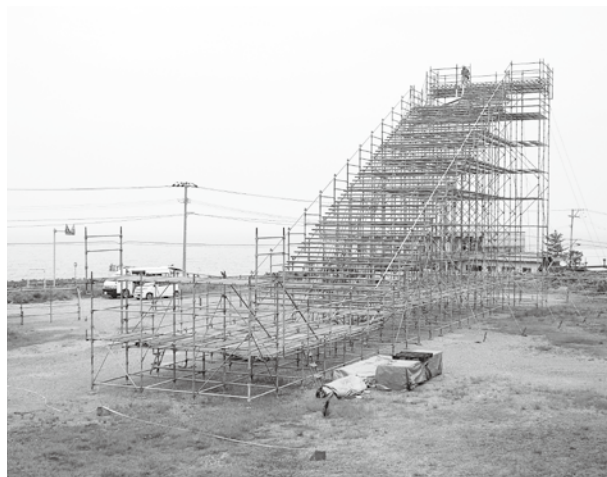
建設途中の夏場用スノーボード練習施設 (瀬波温泉三丁目旧市民会館となり)
