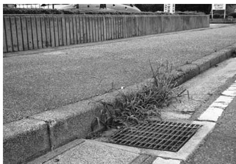
歩道脇で伸びに伸びた雑草
