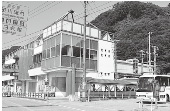
トイレが増設される笹川流れ夕日会館
