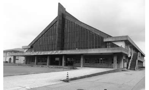
老朽化が著しい荒川総合体育館
