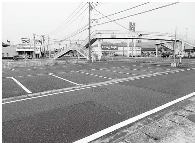
事故後に蓋が設置された事故発生現場（下鍛冶屋）
