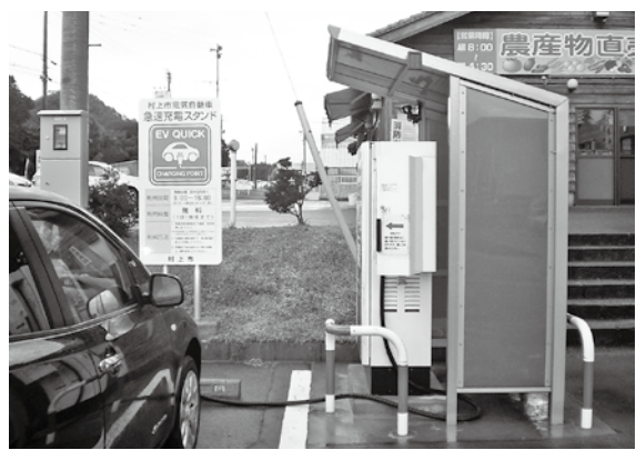
電気自動車の急速充電スタンド（朝日みどりの里）
