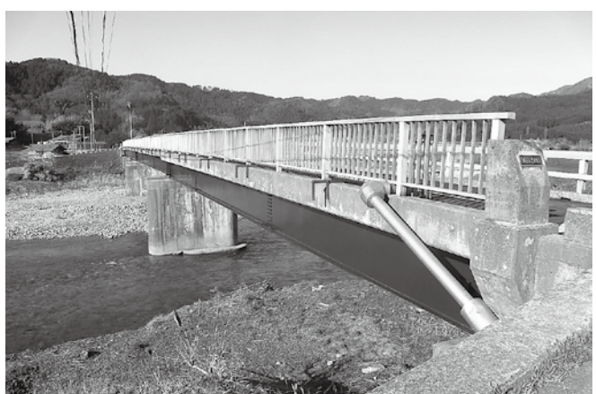
修繕された大谷沢橋
