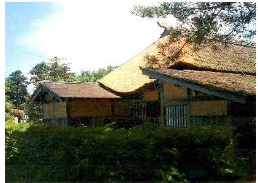
修復後の様子
