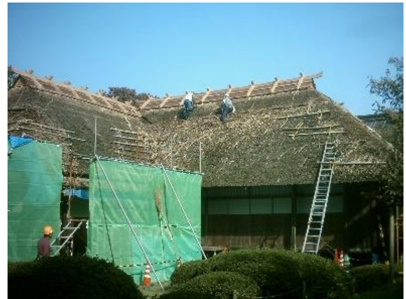
茅葺屋根の葺替えの様子
