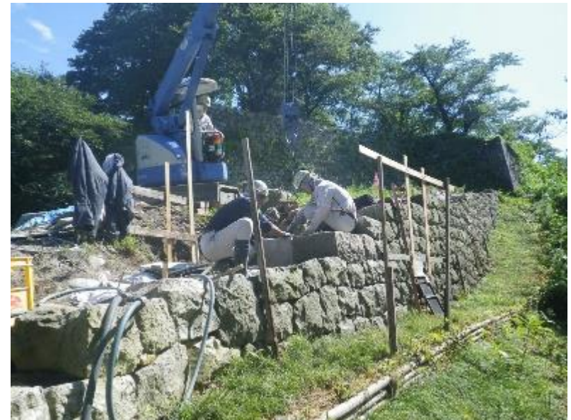
石垣の修復の様子
