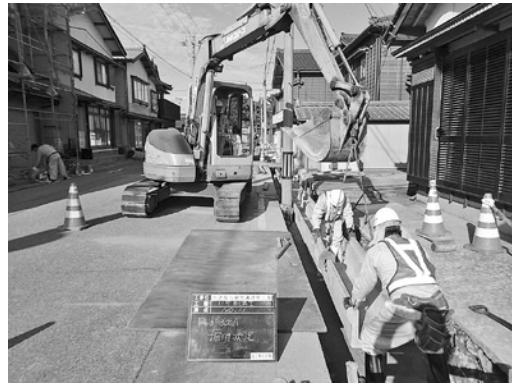
市道の側溝改修工事の様子(塩谷地内)
