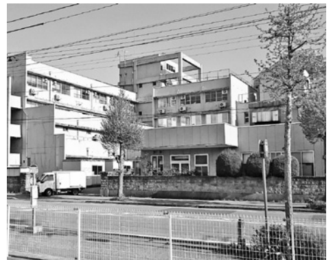
老朽化が進む村上総合病院
