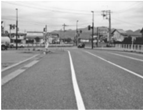
先が進まない瀬波温泉トンネル先線
