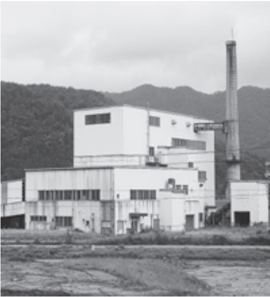
解体撤去される荒川郷ごみ処理場(貝附)
