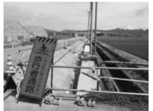
市道桃川牧目線改良工事(牧目地内)
