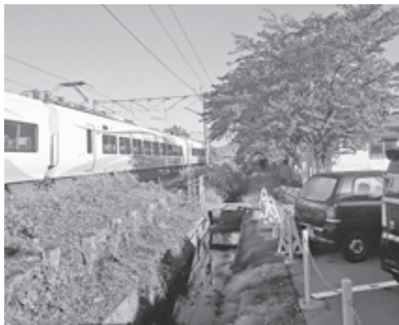
村上いずみ園脇の排水路(山居町二丁目)
