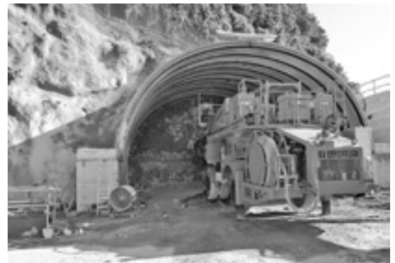
新鶴泊トンネル工事に着手
