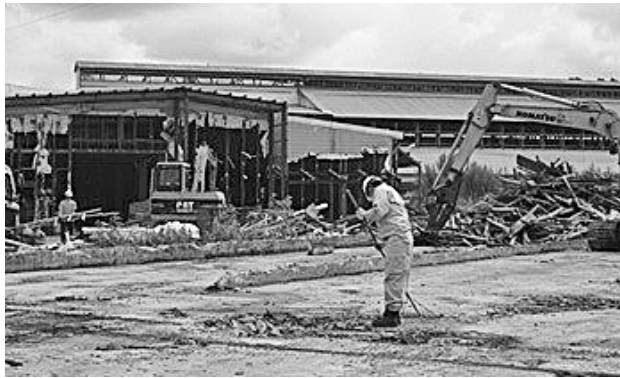
鶏舎の撤去作業の様子
