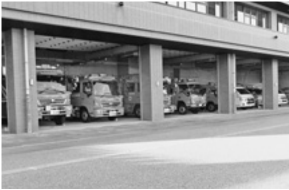
災害時に市民の命を守る消防本部
