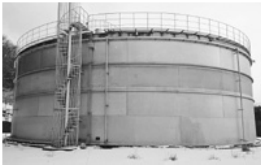
合併前に整備された、1万人の給水タンク(川部)
