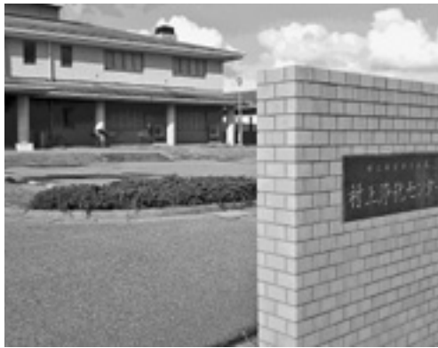
村上市公共下水道 村上浄化センター(瀬波温泉一丁目)
