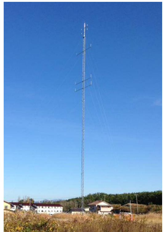
図2 風況観測塔の状況
