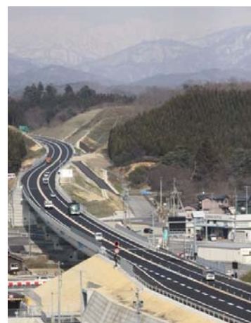
日本海沿岸東北自動車道
