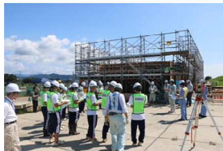
高校生の建設現場見学ツアー
