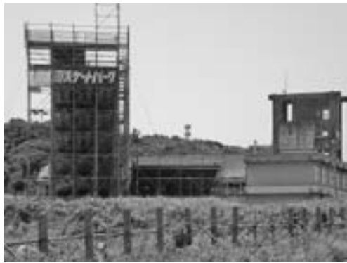
旧村上市市民会館にある日本海スケートパーク
