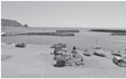
防波堤の断面修復工事が行われる桑川漁港
