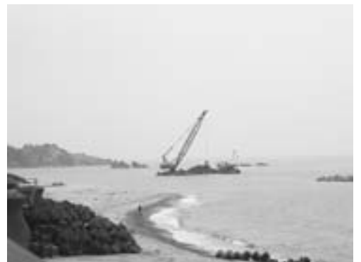
離岸堤の設置工事(寒川海岸)
