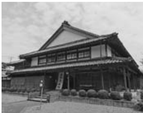
改修により市民ギャラリーとしての利活用が望まれる三の丸記念館
