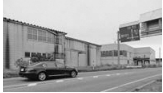
トタンを撤去した国道脇の工場跡
