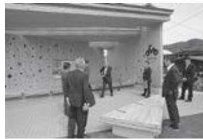
久世駅CLTモデル建築物・公衆トイレ「ホテルラス」(岡山県真庭市)
