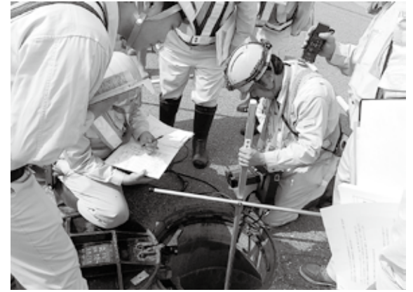
日本下水道事業団と下水道課が合同で行ったマンホール・管渠の巡視点検調査の様子
