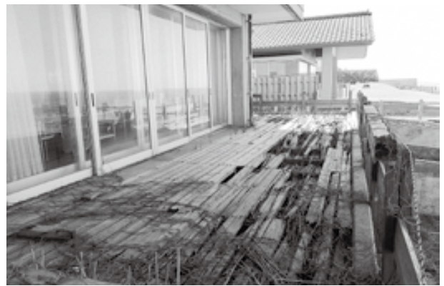
破損が著しい瀬波すみれ荘
