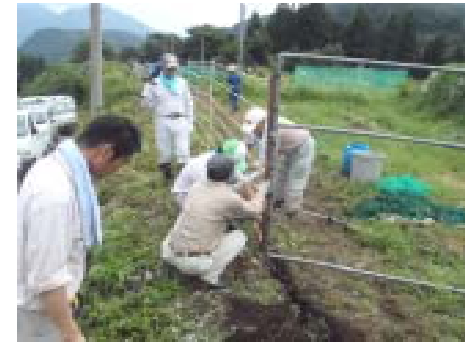
設置作業写真 (集落参加者:23名)
