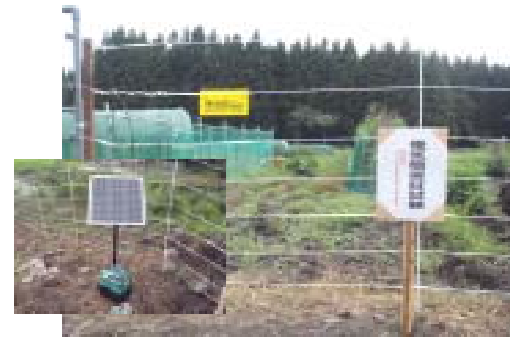
設置完了写真 (周囲:約400m)
