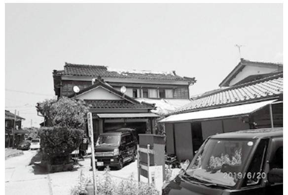
ブルーシートに覆われた被災住宅
