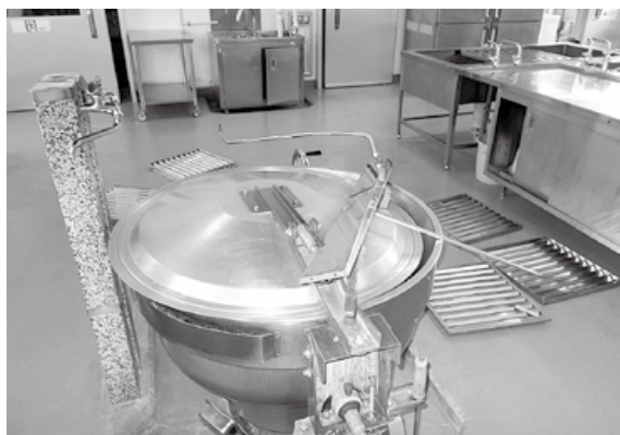
地震の被害を受けた山北学校給食共同調理場
