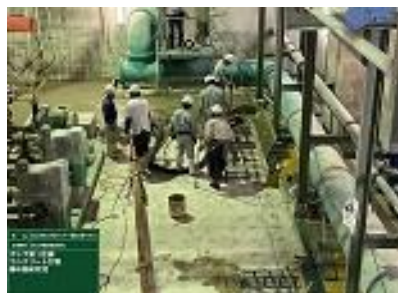
村上浄化センター耐震工事
