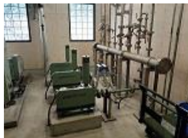
南大平処理場設備更新
