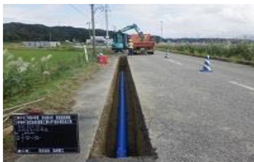
水道管路更新工事
