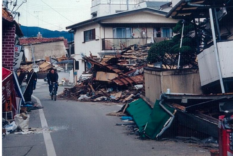
〔図 4.3 地震後の道路閉塞の状況〕
