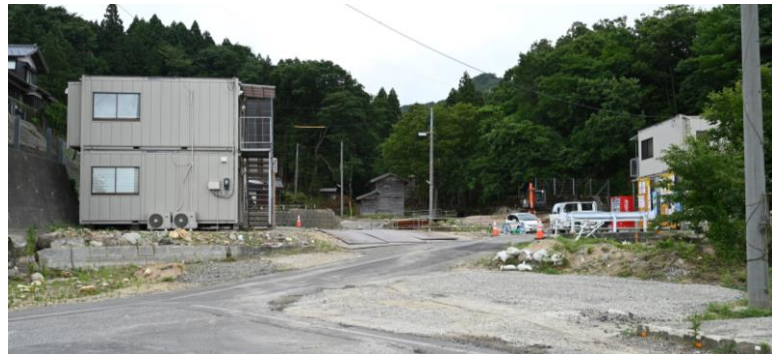
(R5. 7. 3撮影 復旧作業にあたる事業者が事務所を設置)
