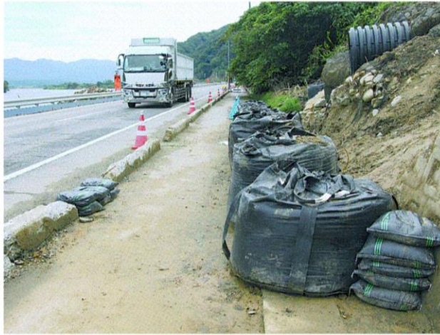
応急復旧工事が完了し、全ての規制が解除された国道113号 村上市
