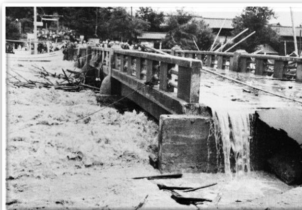
▲石川からの濁流（村上地域 岩船下大町）
