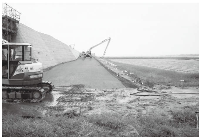
工事が進む（仮称）神林インターチェンジ
