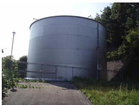
左の写真は、朝日中野配水池(H14)で、岩沢浄水場から送水されます。ステンレス製で緊急遮断弁が整備され、耐震化対応済です。
