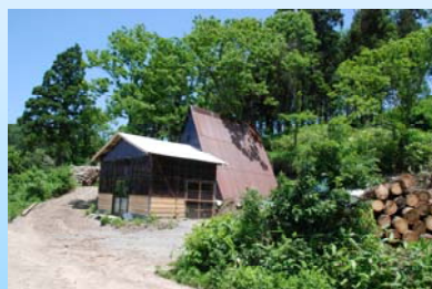
■里本庄炭小屋整備
