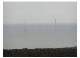
約 12mの海底を水中パワーショベルで掘削整地し、そこにいずれも陸上で制作した 鉄筋コンクリート製のケーソン基礎を台船に乗せて設置現場まで運搬し、一部海底 に沈めて浮力を利用しながら洋上クレーンで設置個所に定着させた後、基礎内部に 高比重の中詰材の銅水砕スラグを注入し固定させた後、陸上で制作したタワー材や 風車本体を組み上げて設置させるものである。
