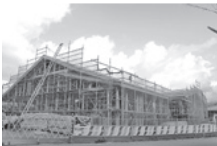
▲来年春の開校に向けて建設中の保内学童保育所
