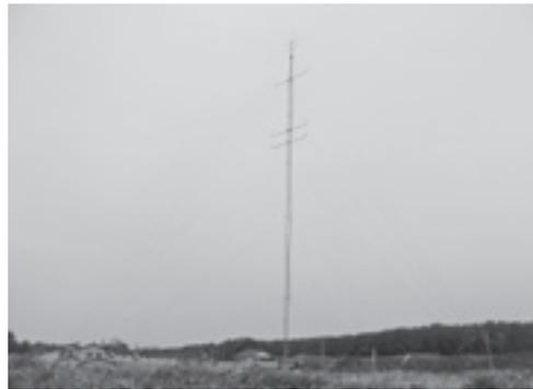
日立造船株式会社（事業予定者代表）が、岩船港脇に高さ約60メートルの風況観測塔を設置して風況観測を開始しました。この風況観測は洋上風力発電の事業性を評価するために必要なもので、1年間かけて風況観測を行います。
