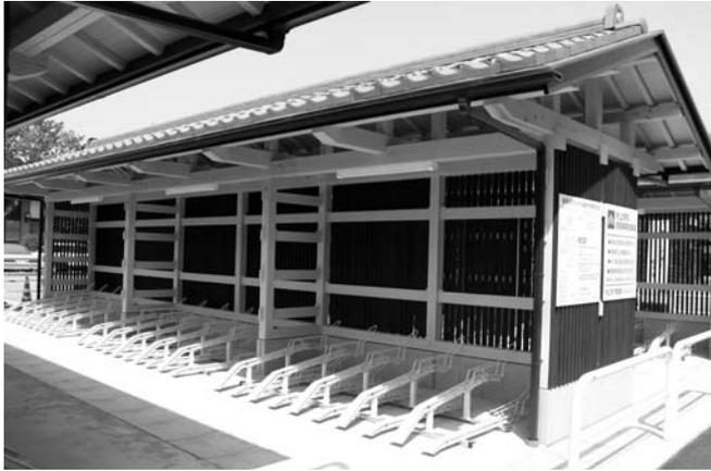
JR村上駅前とJR岩船町駅前に自転車やバイク用の駐輪場が完成しました。村上産の杉を使用し、極力金物を使用しない職人の伝統的構法で、造られています。外観は村上の町屋を意識した見通しの良い暗褐色の木格子を設け、柱・梁・天井は白茶（しらちゃ）色として、明るく温かさの感じる落ち着いた景観となっています。
