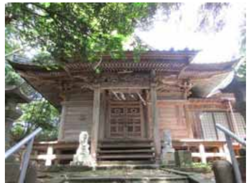
図 管堅八幡宮社殿
