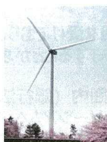
名称 中条風力発電所 場所 新潟県胎内市 容量 2MW(1,990kW)×1基 運開 2014年3月
