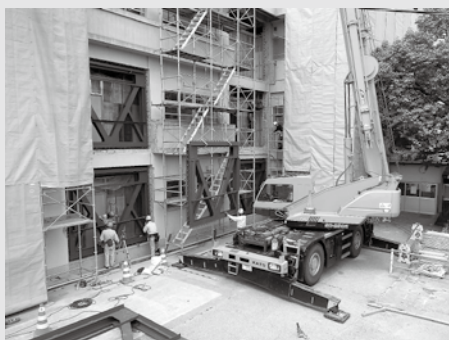
▲耐震補強工事の様子（神納小学校）
