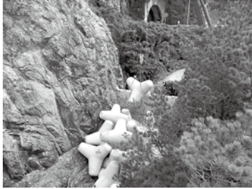
▲消波ブロックを据え付ける（桑川沿岸）
