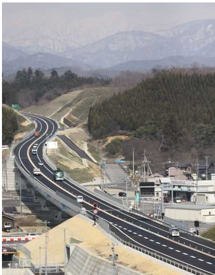
日本海沿岸東北自動車道
