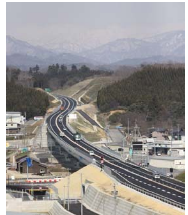
日本海沿岸東北自動車道
