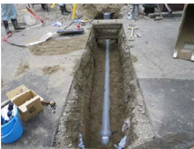
下水道工事の様子
