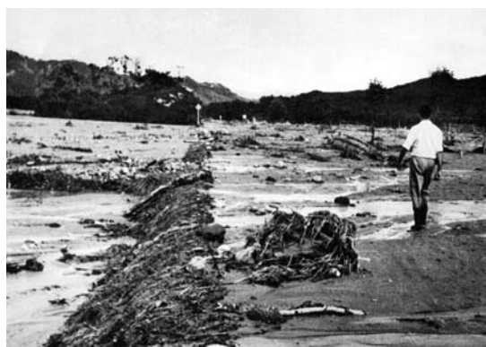
▲通行不能となった国道113号（旧荒川町春木山）
