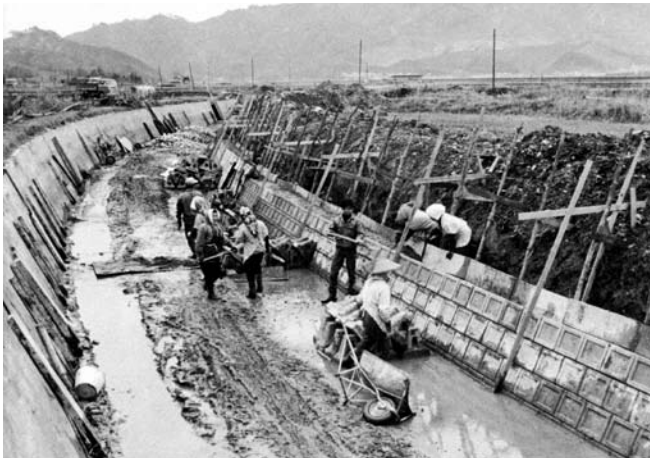
▲神納用水路幅員拡張工事（旧神林村川部）
