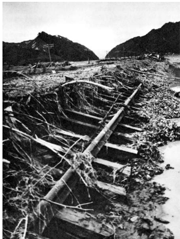
▲破損した米坂線（旧荒川町荒島）
