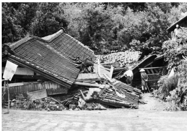
▲破堤と土砂崩れで家屋崩壊（旧神林村山田）
