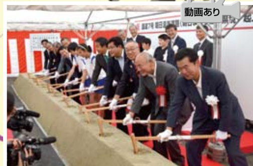
▲本線着工の起工式（9月9日）
