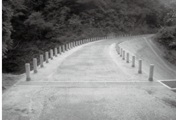
▲林道上田沢線改良工事（関口地内）
