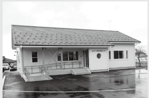
▲あらかわ病児保育センターを建設
