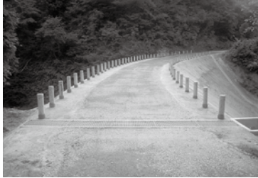
▲林道上田沢線改良工事（関口地内）
