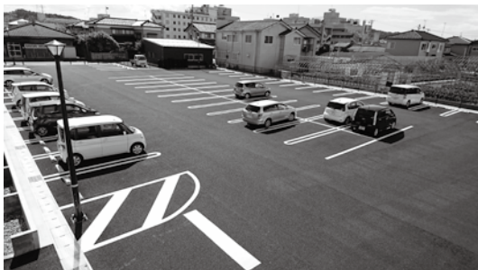
▲駐車場を拡張（マナボーテ村上）
