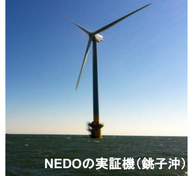
【洋上風力発電設備のイメージ】
