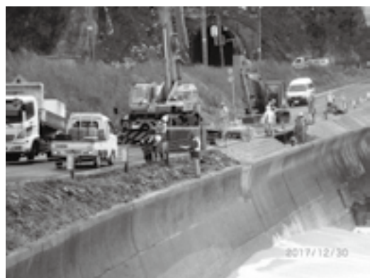
国道345号の災害復旧工事（板貝）
