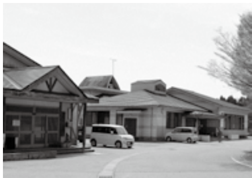
道の駅の重要な施設として、早期の改修が必要なまほろば温泉と体験交流センター
