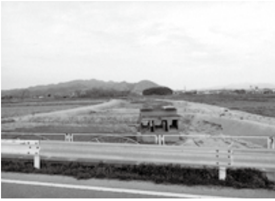
村上総合病院移転新築に伴い整備される市道緑町松山線の工事箇所
