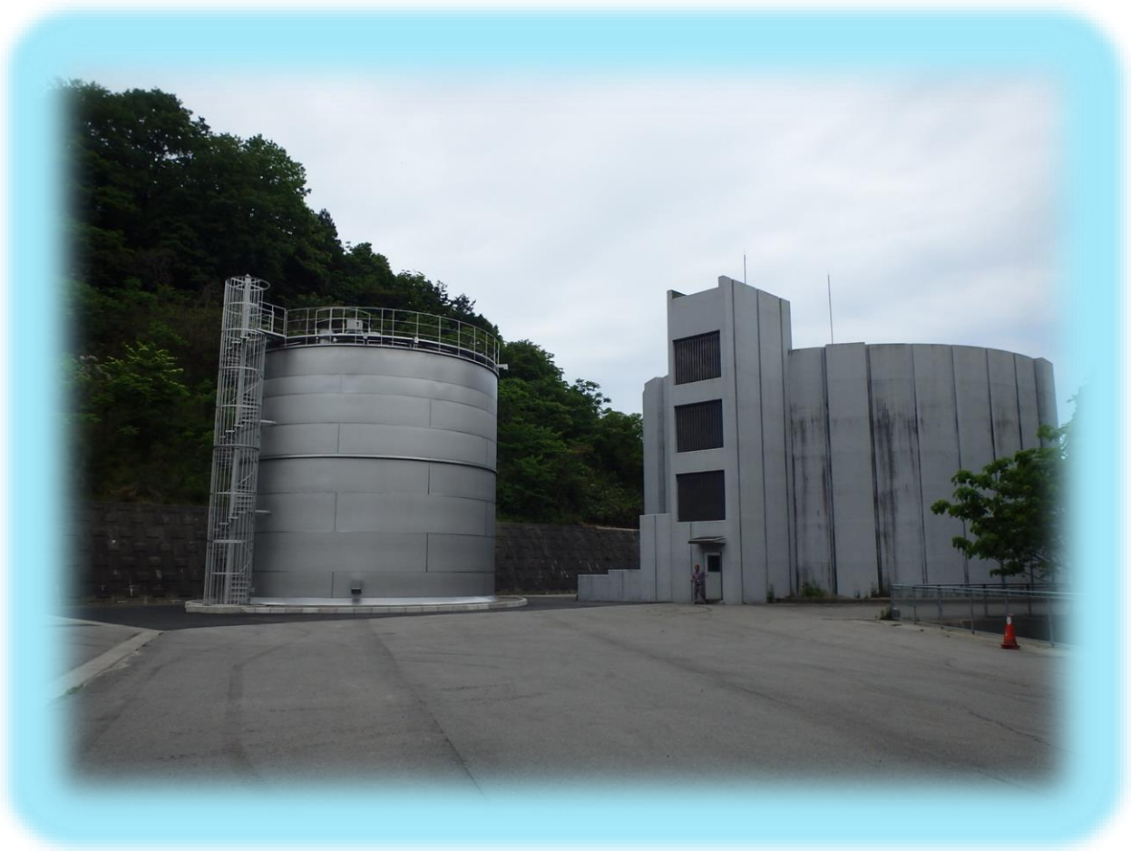
写真:愛宕山配水池
